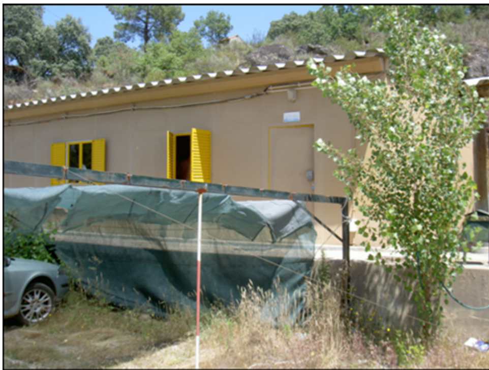
Fotografia 2: Escritórios e Instalações Sanitárias
