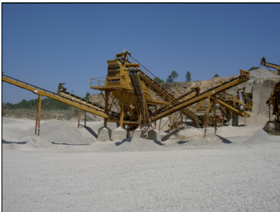
Fotografia 1: Vista parcial da Instalação de Britagem
